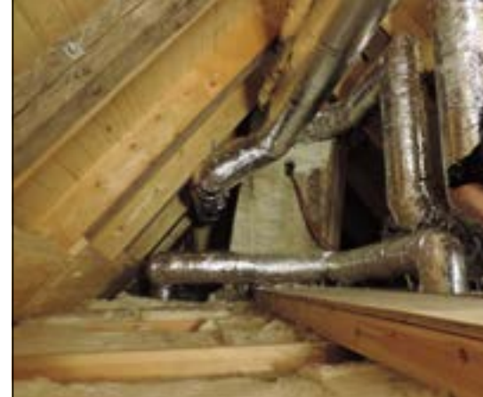
Installatør samler ventilation på kiploft i Mern.
