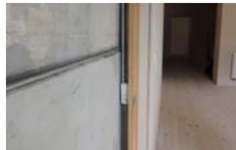
Hulrum til udluftning af forurening fra undergrund.
