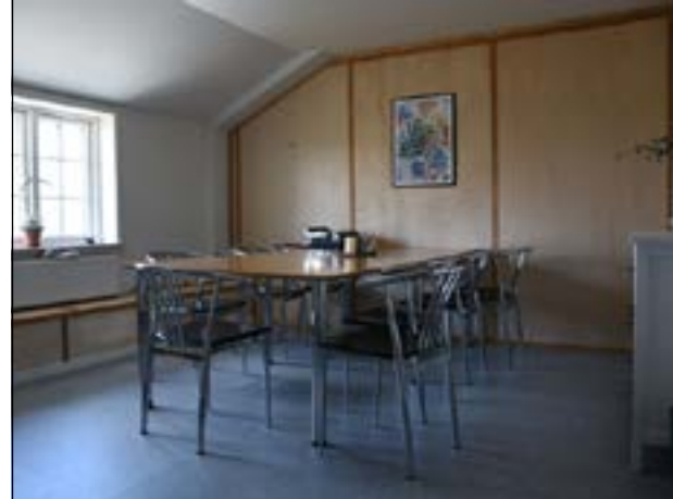
Installationsbænk til venstre og vægge af birkefiner.
