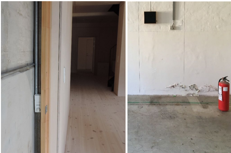
FIGUR 27. Samling mellem 'Hus i Hus' konceptet og den gamle ydervæg på billedet til venstre. Fugt gennemslag nedst på væg i opgang på billedet til højre. Foto: Niels Haldor Bertelsen (2021).
