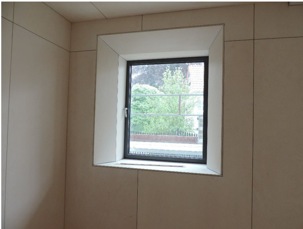
FIGUR 20. Indvendig facade i 'Hus i Hus' konceptet, som er af moduler i birkefiner, og hvor vinduet her er uden sprosser og med bred lysning med godt lysindfald. Modulerne var planlagt til præfabrikation, men de blev fremstillet på stedet af håndværker. Foto: Niels Haldor Bertelsen (2020).
