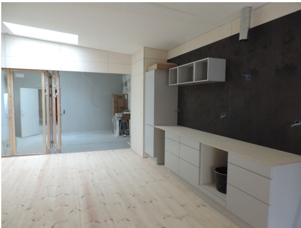
FIGUR 21. Køkken med udsigt til rå, uopvarmet rum. Foto: Niels Haldor Bertelsen (2020).
